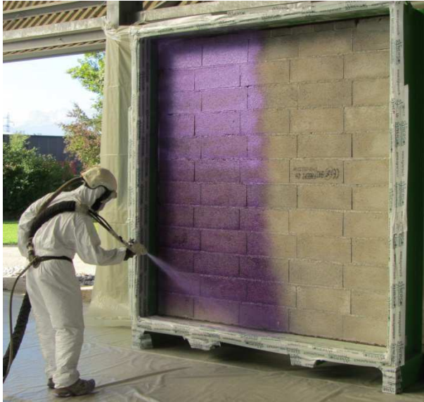
Figures 3 et 4 : Photographies du procédé de projection de l'isolant
