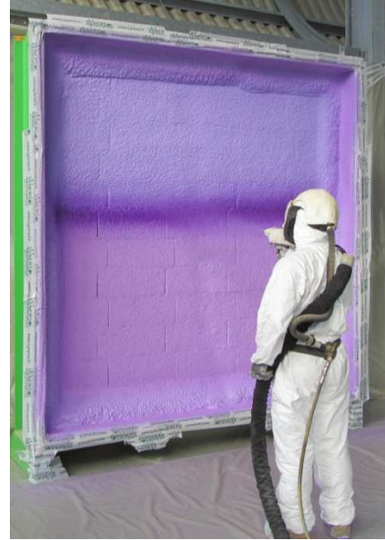
Figures 3 et 4 : Photographies du procédé de projection de l'isolant
